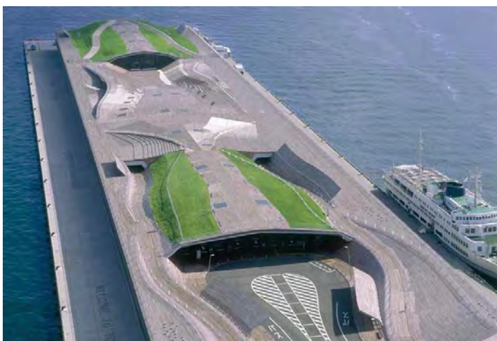
TERMINAL INTERNACIONAL DE PASAJEROS Yokohama (Japón) Foreign Office Architects (FOA) 2002
