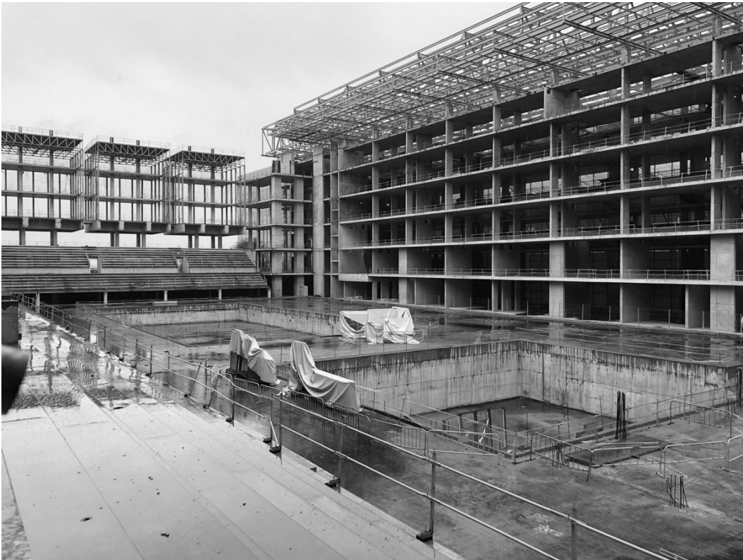
Edificio abandonado para el Centro Acuático del Madrid Olímpico.
